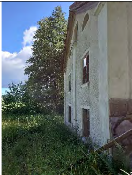
Nordöst fasad på kvarnbyggnad
