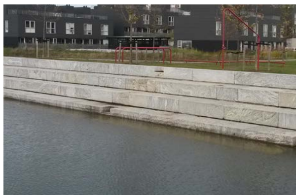
Figur 5:31. Strandskoning för att förhindra erosion. Erosionrisken ökar med höga havsnivåer.
