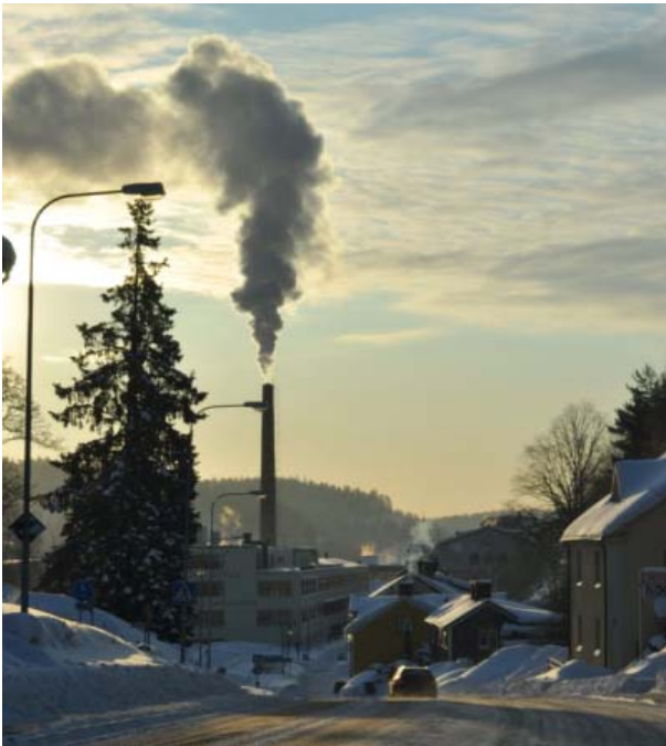
Figur 3:15. Fjärrvärme i Valdemarsvik
