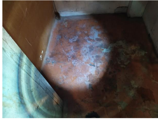
Figur 4. Foto från det utrymmet där pannan stod innan den togs ur bruk.
