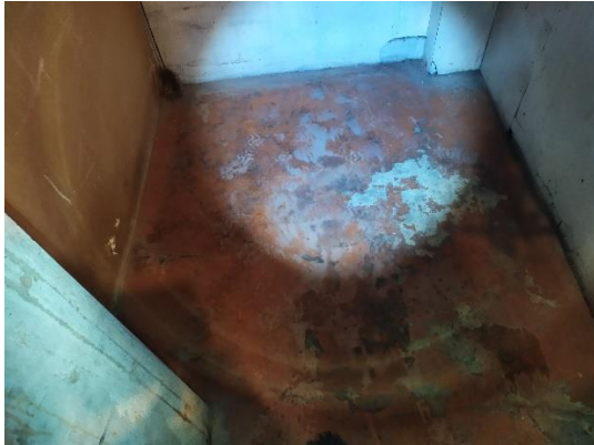
Figur 3. Foto från det utrymmet där pannan stod innan den togs ur bruk.
