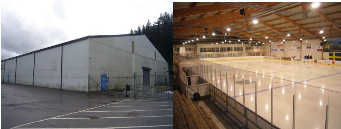
Figur 4. Foto utsida från nordväst samt insida sett från läktaren mot isrink och uppvärmda lokaler i ishallen, vid platsbesök 2021-08-16.
