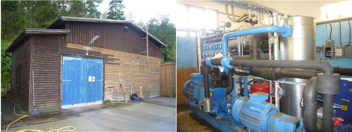
Figur 6. Foto på framsida komplementbyggnad för garade och köldaggregat samt foto på köldaggregat, vid platsbesök 2021-08-16.
