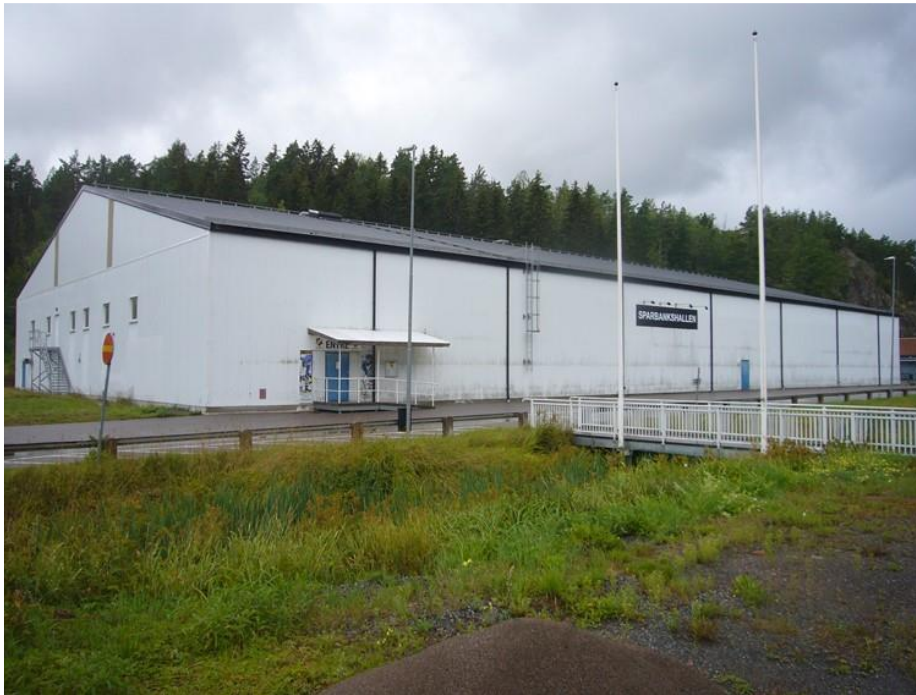
Figur 3. Foto utsidan av ishall vid platsbesök 2021-08-16.
